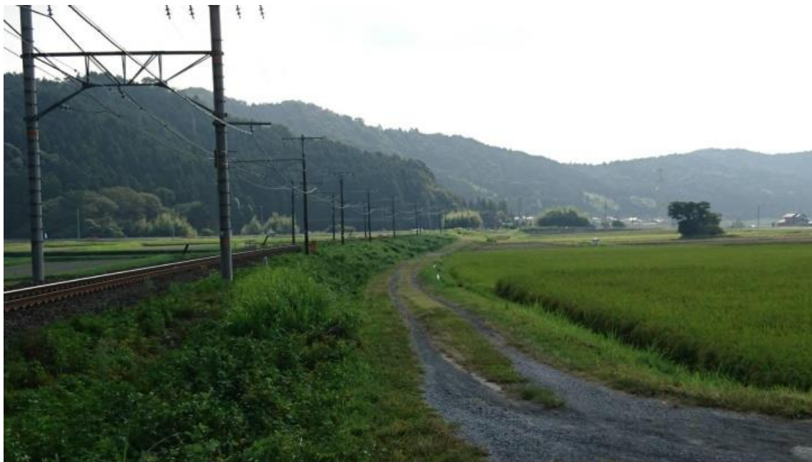
関ヶ原方面から大垣方面を望んだ新垂井線
